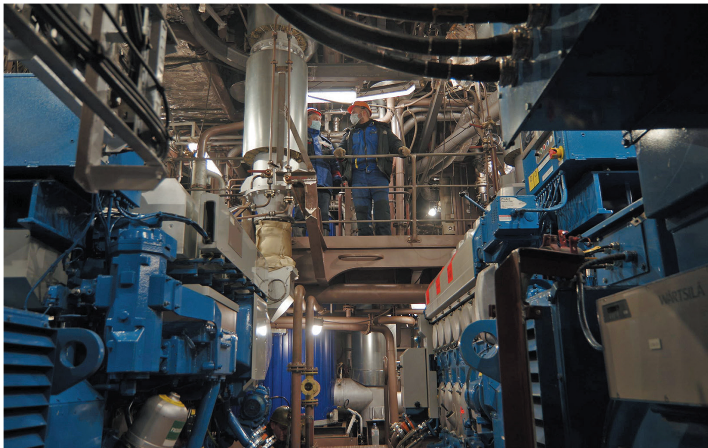
В апреле 2022 года на платформе завершены швартовные испытания дизель-генераторов и генераторов, продолжают швартовные испытания главного дизеля и винторулевого комплекса. Фото: aoosk.ru
